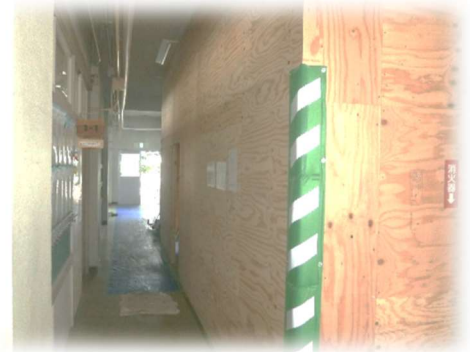
「トイレ改修作業」の様子
