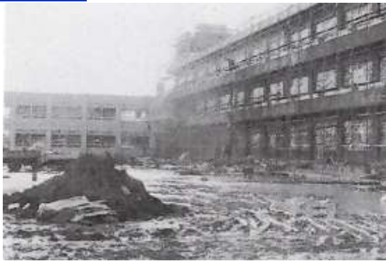
昭和 54 年 建築中の校舎
