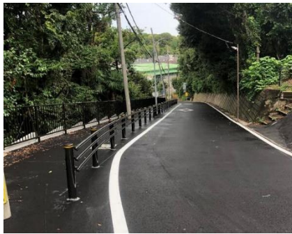
がんばり坂補修工事完了
